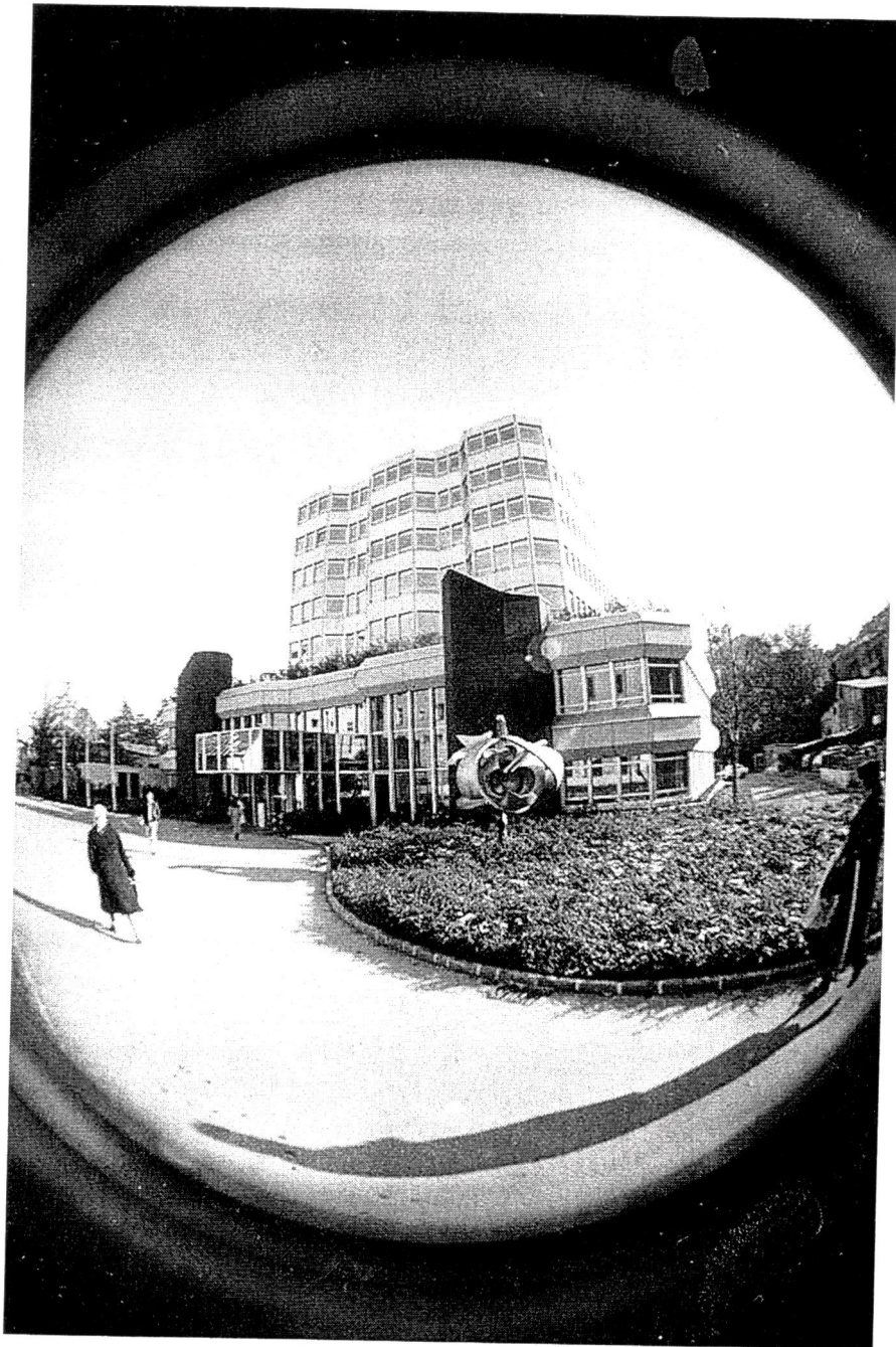
Abb. 16: Das heutige Verwaltungsgebäude der Tiroler Gebietskrankenkasse, das im Sommer 1976 bezogen wurde.
